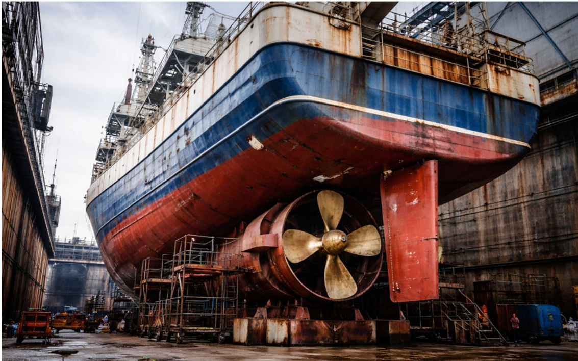
VISTA GENERAL DEL SECTOR DE POPA DE DONDE SE EXTRAJO EL TROZO DE PLANCHA ANALIZADO.
